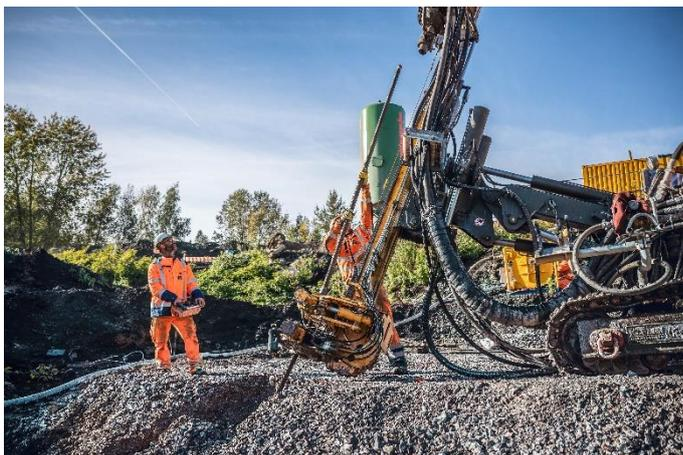
(3) Insgesamt werden 140 Mikropfähle an den Einzelfundamenten der neuen Brücke hergestellt.
