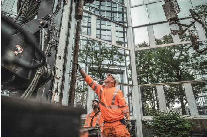
(3) 45 Erdwärmesonden stellte das Bauer-Team bis in 100 m Tiefe mittels Spülbohrverfahren her.
